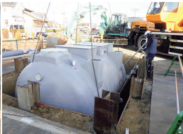
タイプ1の高効率プロワ（左）とタイプ2の本体交換施工状況
