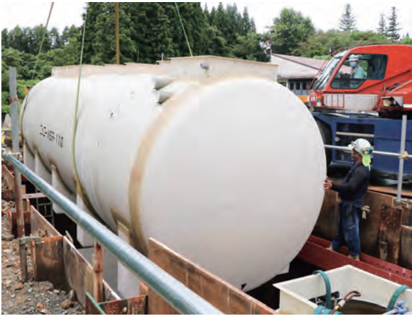
会津美里町で行われた本体交換作業（タイプ2）
