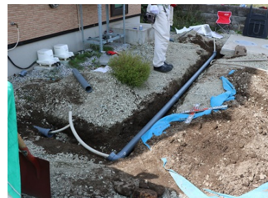
写真-7 再敷設の状況
