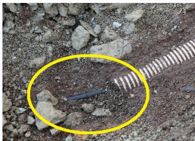
写真-6 ケーブルの露出
