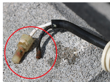
写真-4 端子の腐食
