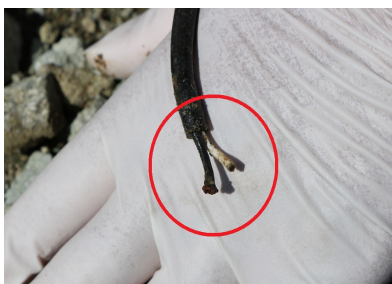
写真-3 再接続箇所での断線
