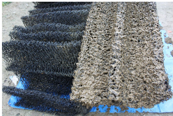
【写真－４】槽外に引き上げた“立体網状”ろ材
