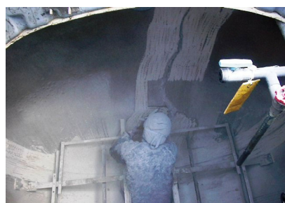
写真-11 補修作業(研磨)
