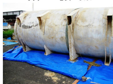
写真-6 支持脚部の復元と補強
