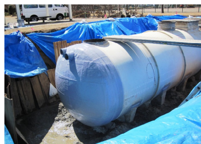
写真-10 補修後の状況
